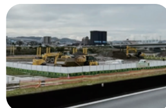
豪雨に備えた多摩川底の掘削工事
